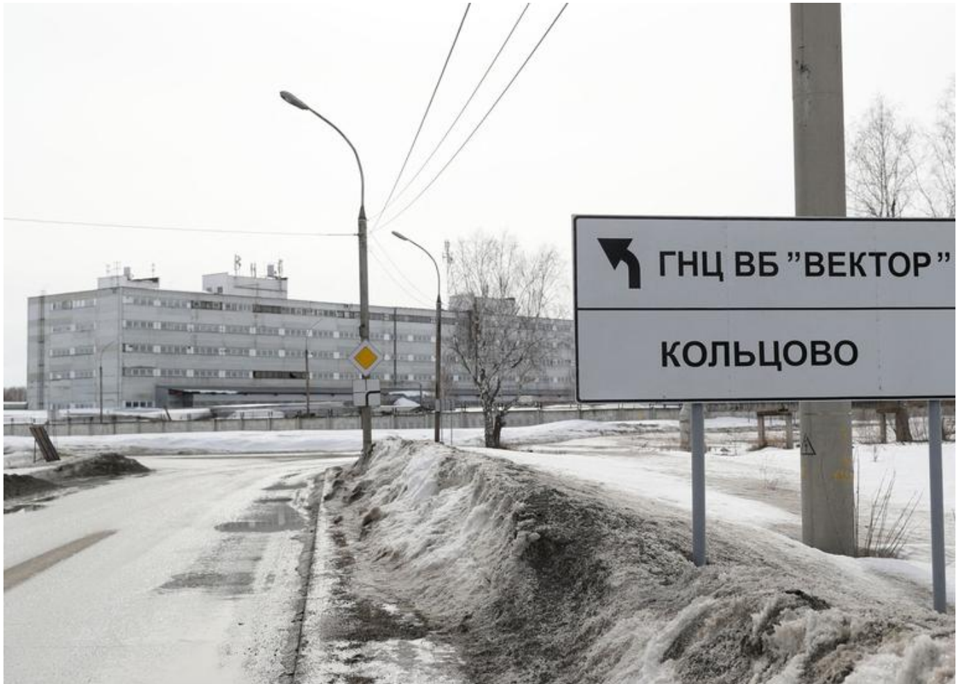
Vue du Centre de recherches d'État pour la virologie et la biotechnologie, situé à 30 kilomètres de Novossibirsk (photo datant du 17 mars 2020). Tass/Tass/ABACA
